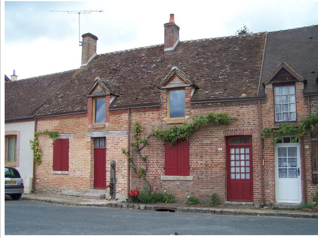
Construction avec façade en brique, corniche sous toiture en petites tuiles de terre cuite.
